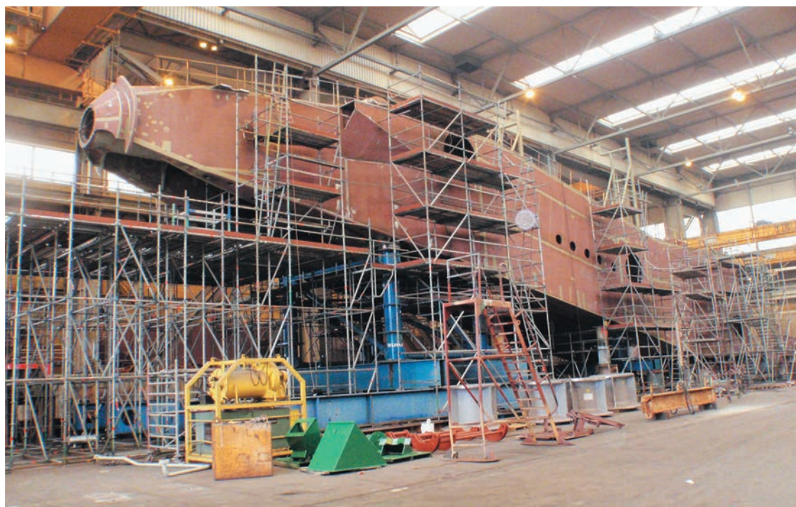
De bouw van de Athena bij IHC Dredgers in Kinderdijk.
